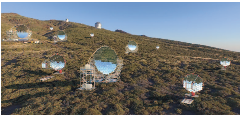
Wizualizacja przyszłego obserwatorium CTAO-Północ w Obserwatorium Roque de los Muchachos na La Palmie (Hiszpania). Planowany układ sieci teleskopów obejmuje cztery duże teleskopy (LST) oraz dziewięć średnich (MST). Źródło: CTAO, CC BY-NC-ND 2.0.
