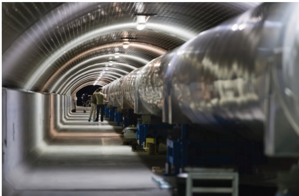
Jeden z 3-kilometrowych tuneli detektora Virgo, w których przemieszcza się światło laserowe © Cyril FRESILLON / Virgo / CNRS Photothèque
